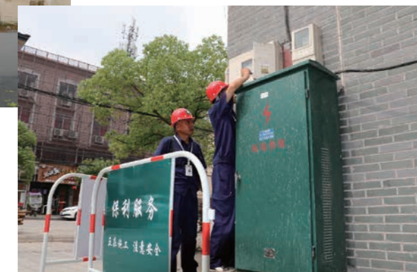
工程人员对沿街设备进行日常维护
