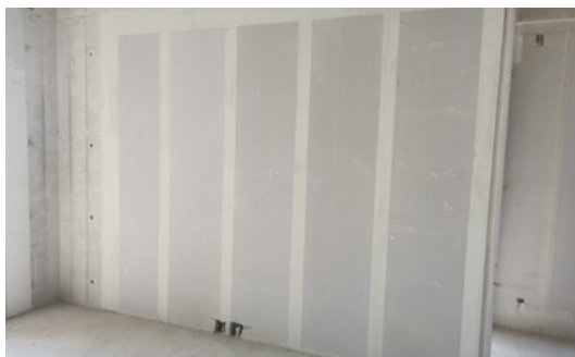
◎ ALC 墙板施工工艺
