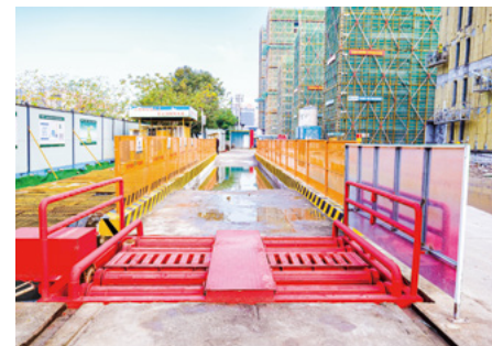
◎ 循环水排污水处理系统
