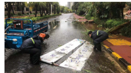
◎ 消除因台风“查帕卡”造成的路面隐患
