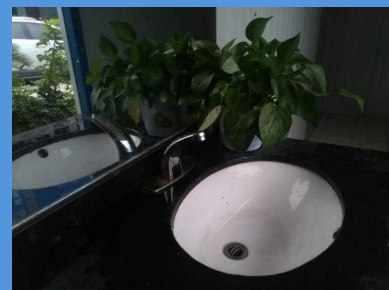
施工现场采用自动感应水龙头
