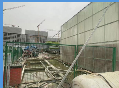
施工现场设置雨水收集池
