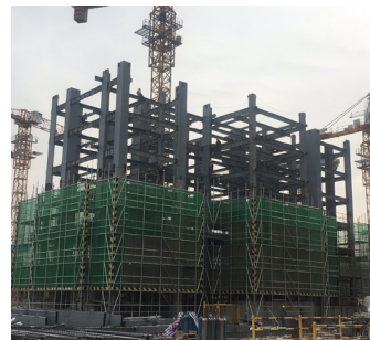
地块项目钢结构住宅标准层施工
