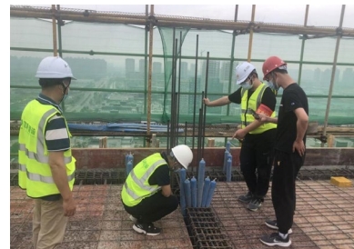
可充放气柔性气囊现场运用
