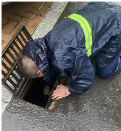
物业公司提前疏通下水管道、搭建防汛堤坝
